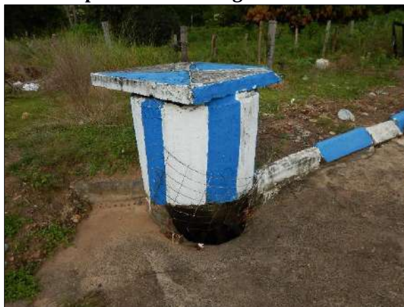
Figura 65. Boca de lobo utilizado para destinar a água de chuva ao córrego no distrito de Buriti
