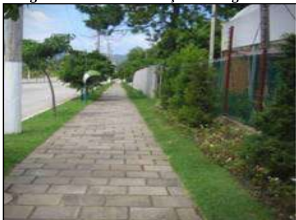
Figura 96. Vala de retenção ao longo da rua
