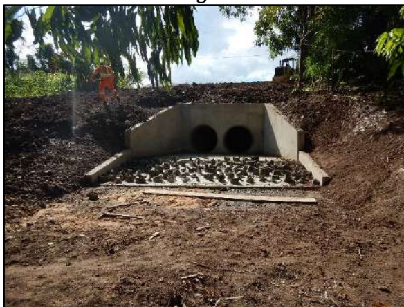
Figura 35. Dispositivo dissipador de energia da obra de drenagem em andamento
