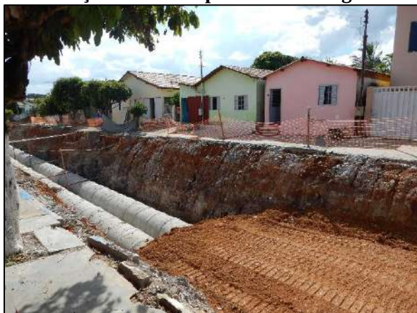
Figura 34. Vista da obra de drenagem em execução no município de Alto Araguaia
