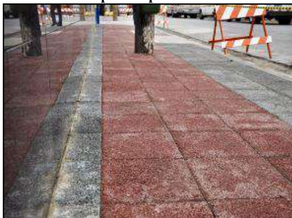
Figura 92. Pavimento poroso instalado em passeio público
