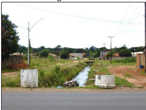
Figura 29. Tubulações lançando esgoto no córrego Mané Falado
