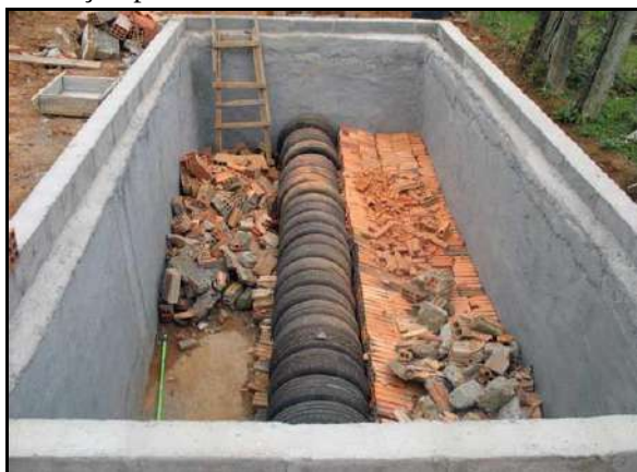
Figura 83. Método do círculo de bananeiras em execução para tratamento individual
