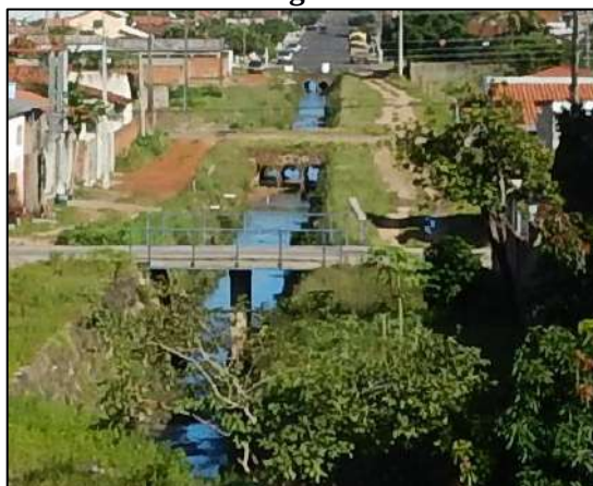
Figura 32. Vista do córrego Mané Falado canalizado
