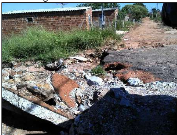
Figura 33. Asfalto danificado
