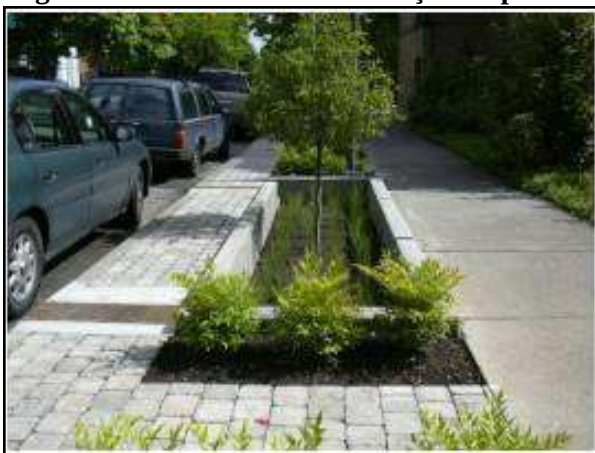
Figura 94. Trincheira de infiltração no passeio
