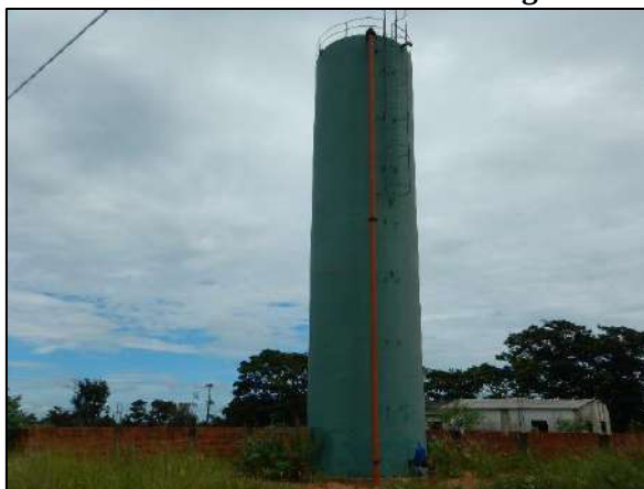
Figura 20. Reservatório novo de 100 m³, abastecerá o bairro Jd. Novo Araguaia
