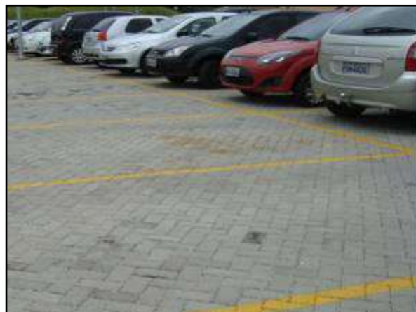
Figura 93. Pavimento poroso instalado em estacionamento
