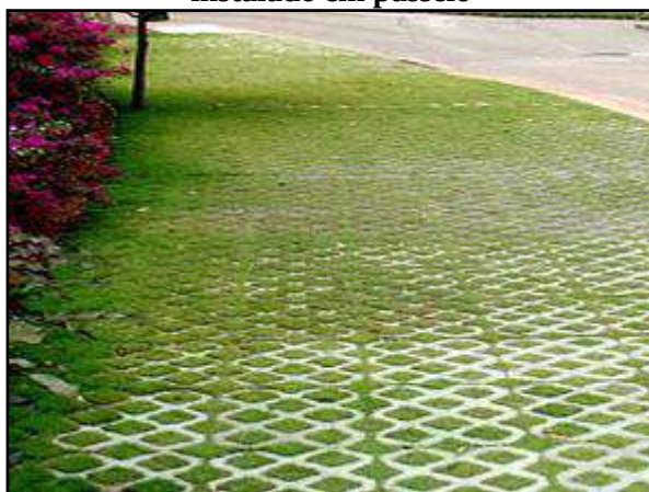
Figura 91. Pavimento poroso – concregrama instalado em passeio
