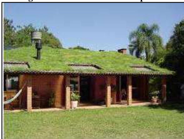
Figura 89. Telhado verde com plantas
