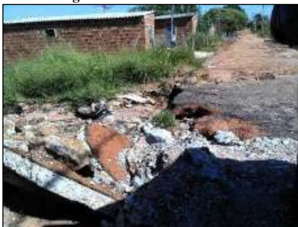
Figura 33. Asfalto danificado
