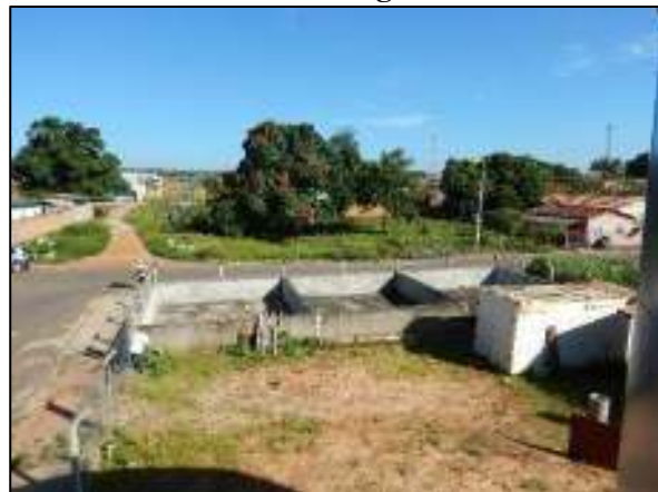
Figura 27. Vista do leito de secagem da ETE de Alto Araguaia
