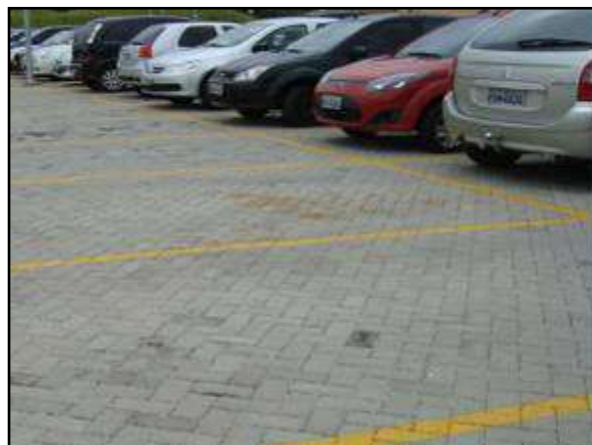
Figura 93. Pavimento poroso instalado em estacionamento
