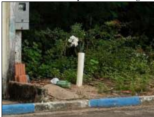
Figura 64. Fossa rudimentar utilizada para “tratar” o esgoto no distrito Buriti
