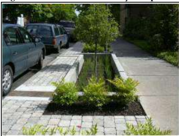
Figura 94. Trincheira de infiltração no passeio
