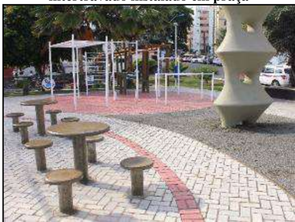
Figura 90. Pavimento poroso – piso intertravado instalado em praça
