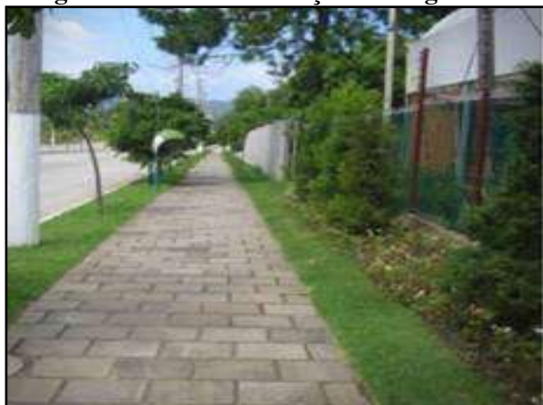
Figura 96. Vala de detenção ao longo da rua
