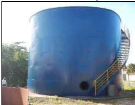
Figura 26. Vista do reator anaeróbio de fluxo ascendente em Alto Araguaia
