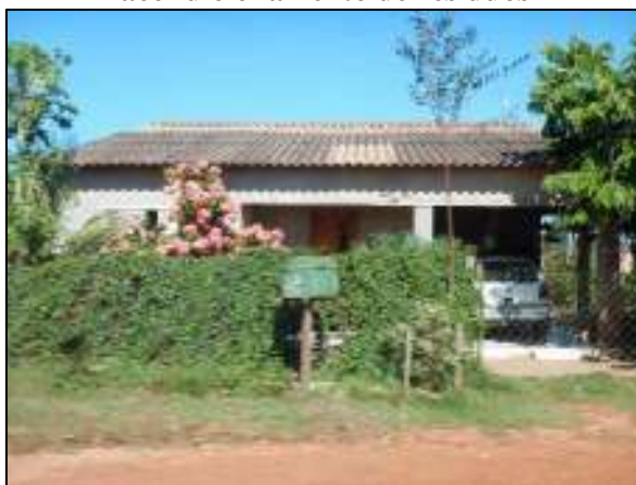
Figura 42. Tambor suspenso para acondicionamento de resíduos
