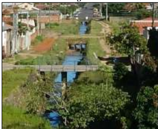
Figura 32. Vista do córrego Mané Falado canalizado
