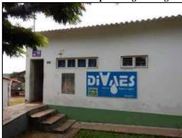
Figura 6. Vista da sede da Divisão Municipal de Água e Esgoto de Alto Araguaia
