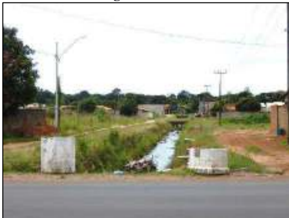
Figura 29. Tubulações lançando esgoto no córrego Mané Falado
