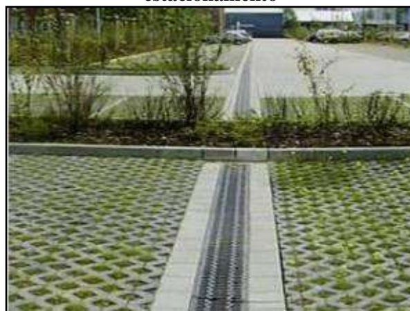
Figura 95. Trincheira de infiltração no estacionamento
