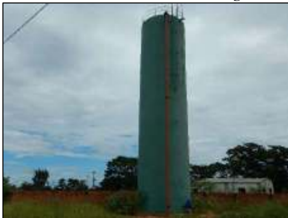
Figura 20. Reservatório novo de 100 m³, abastecerá o bairro Jd. Novo Araguaia
