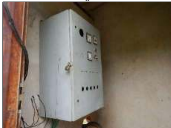
Figura 13. Painel de controle utilizado para automatizar a captação no córrego Sapé, em Alto Araguaia-MT
