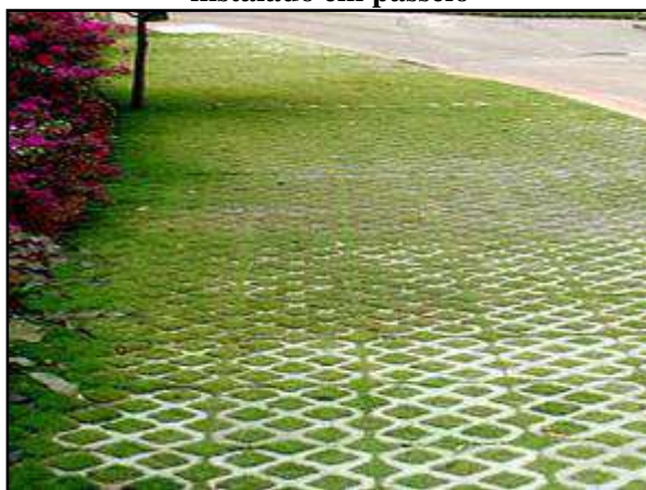
Figura 91. Pavimento poroso – concregrama instalado em passeio
