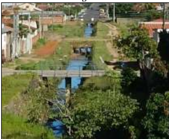
Figura 32. Vista do córrego Mané Falado canalizado
