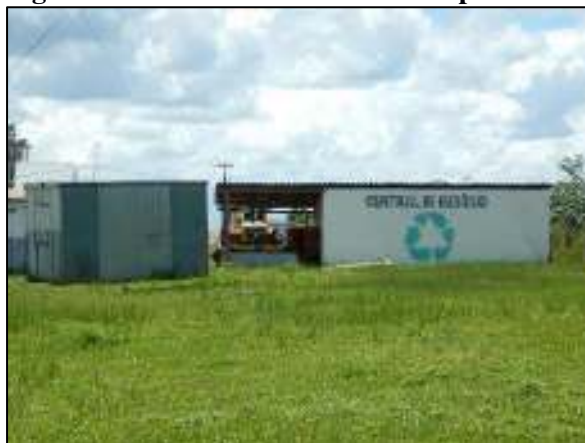
Figura 59. Central de resíduo da empresa ALL
