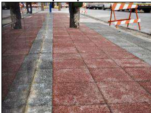
Figura 92. Pavimento poroso instalado em passeio público
